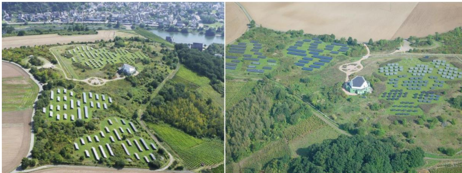
Fot. 7,8 Przy dobrym projekcie parku solarnego czego przykładem jest obiekt Gondorf Kobern w Niemczech, stworzono nie tylko miejsce atrakcyjne dla ptaków, ale obecnie chroni się go na prawach rezerwatu dla zagrożonych gatunków roślin i zwierząt (Źródło: http://vivasolar.de/ )
