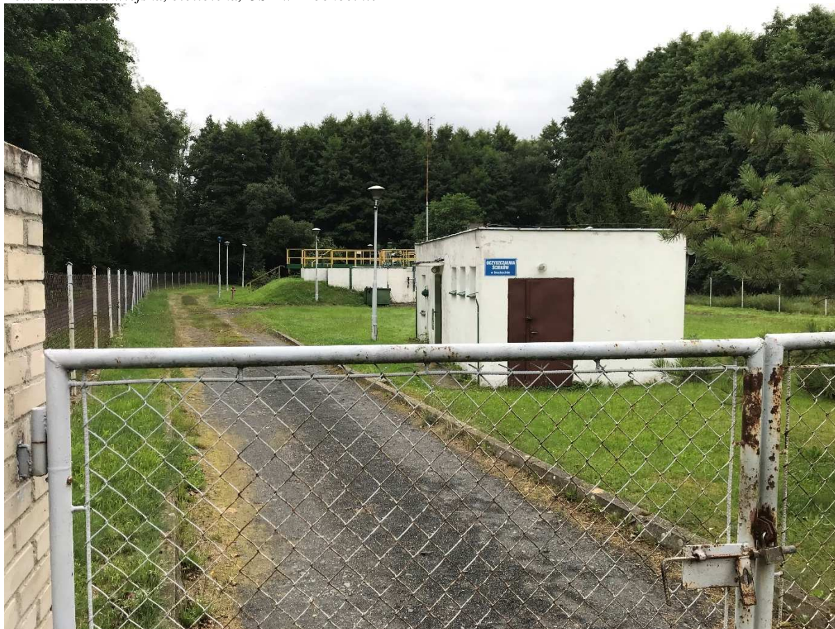
Fot.6. Oczyszczalnia ścieków w Brochocinie
