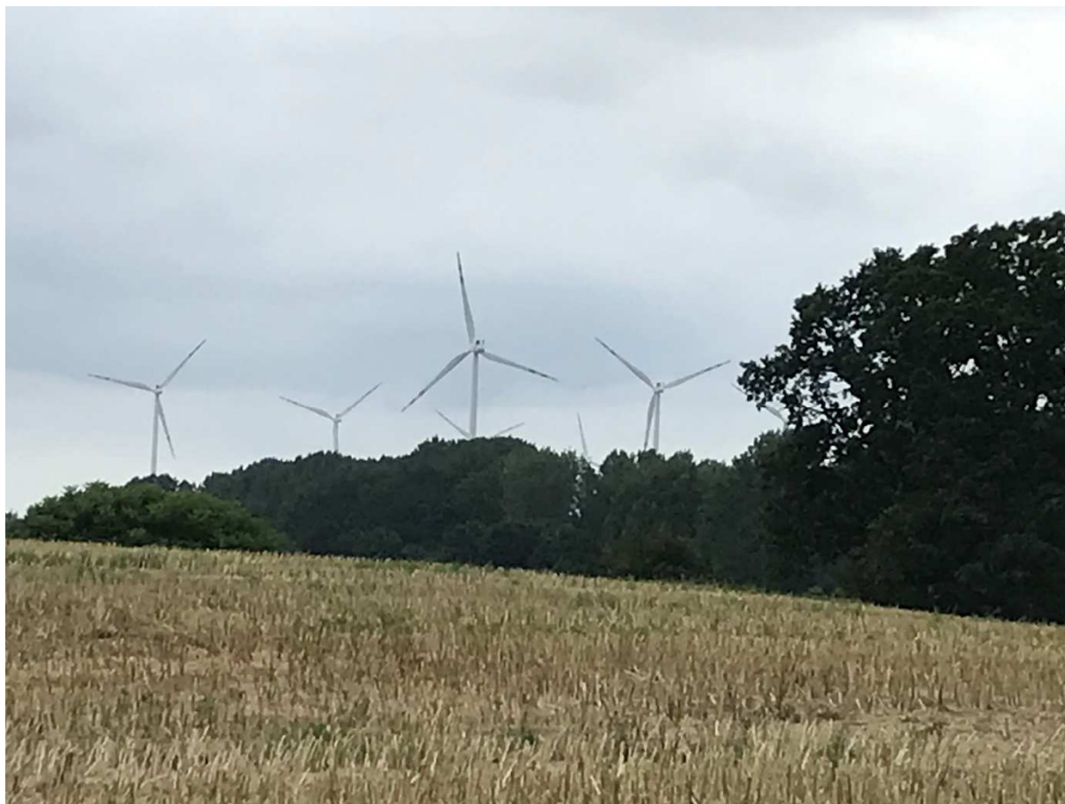
Fot. 7. Widok na siłownię wiatrowe (farma siłowni wiatrowych o nazwie Talia, liczy 12 turbin o mocy 2 MW każda)
